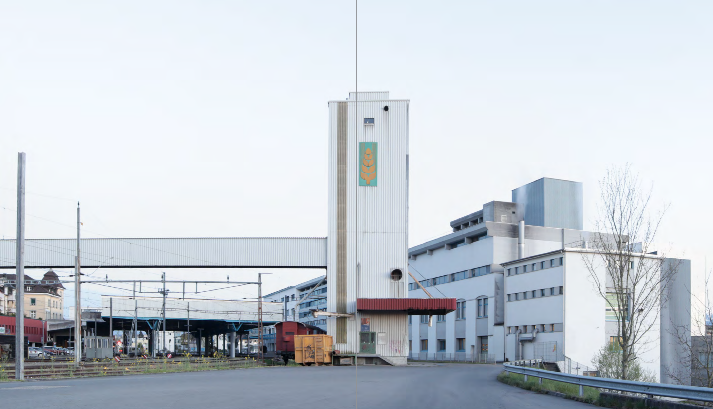
Abb. 3 Südiareal aus nördlicher Richtung
