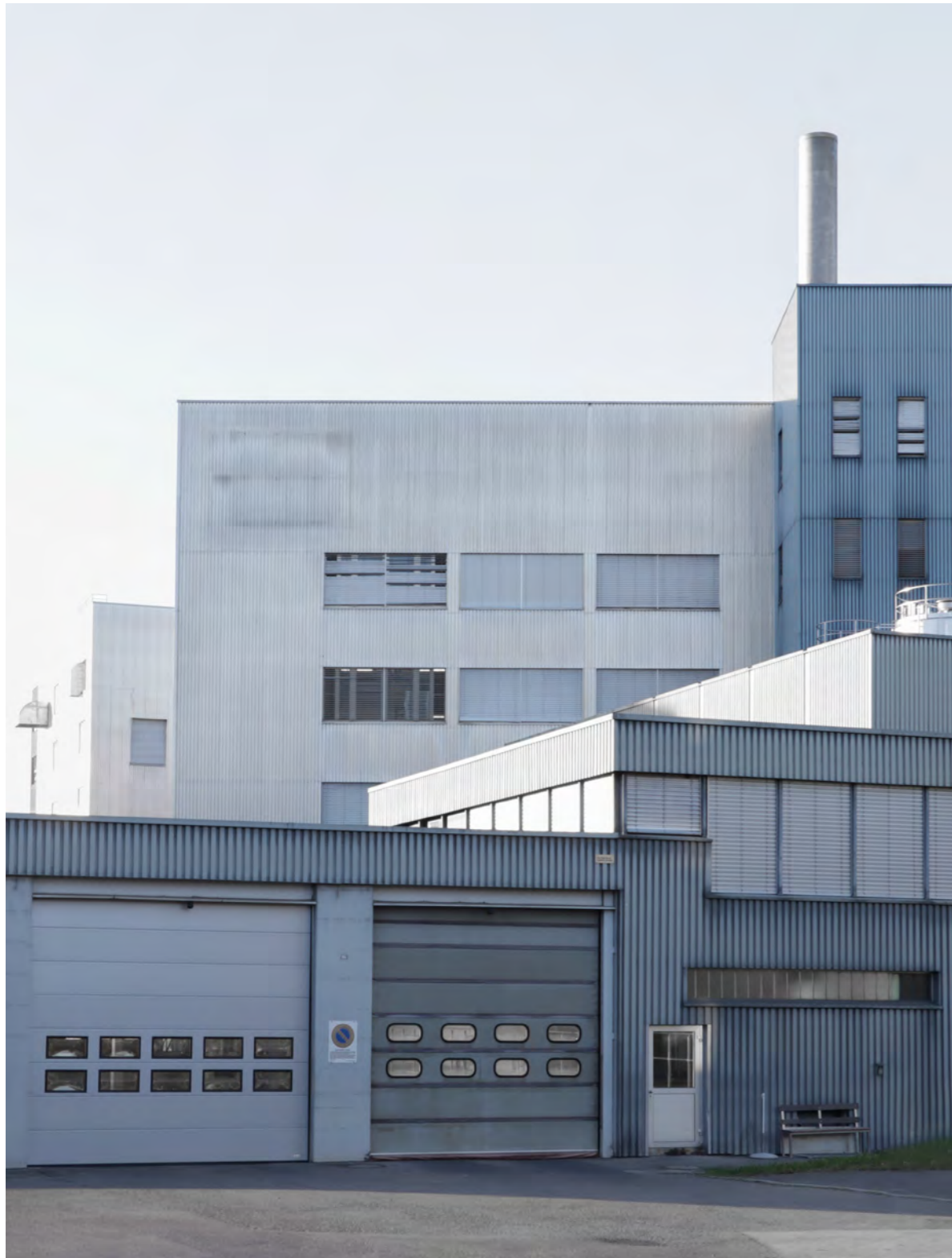
Abb. 4 Warenumschlag am südlichen Arealrand
