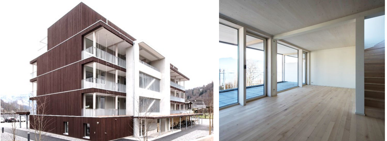
Abbildung 63: neuRaum, Mehrfamilienwohnhaus Horw. schaeerholzbau
