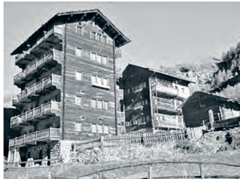
Früher Zeitzeuge der Vertikalverdichtung in Holz – Tour de Valais
