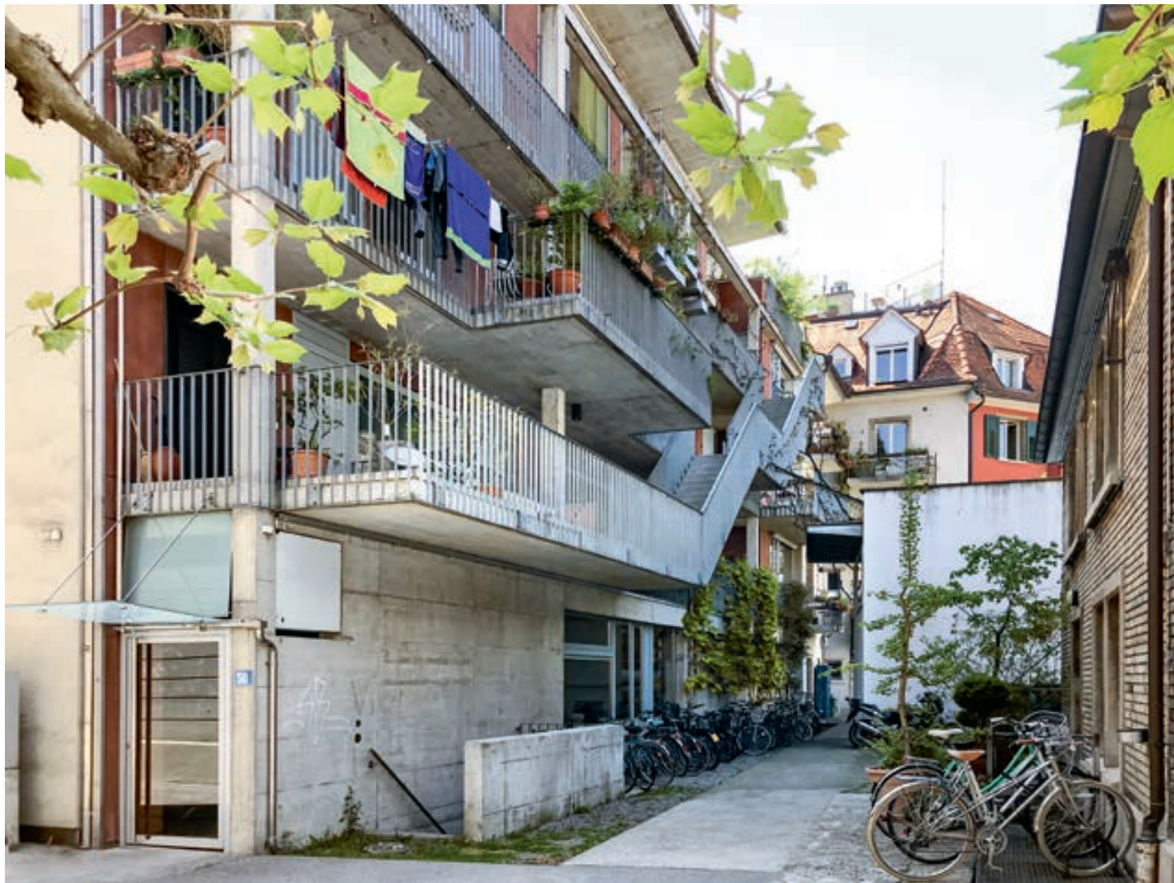
4 BLICK VOM HOF AUF DIE WOHNUNG
