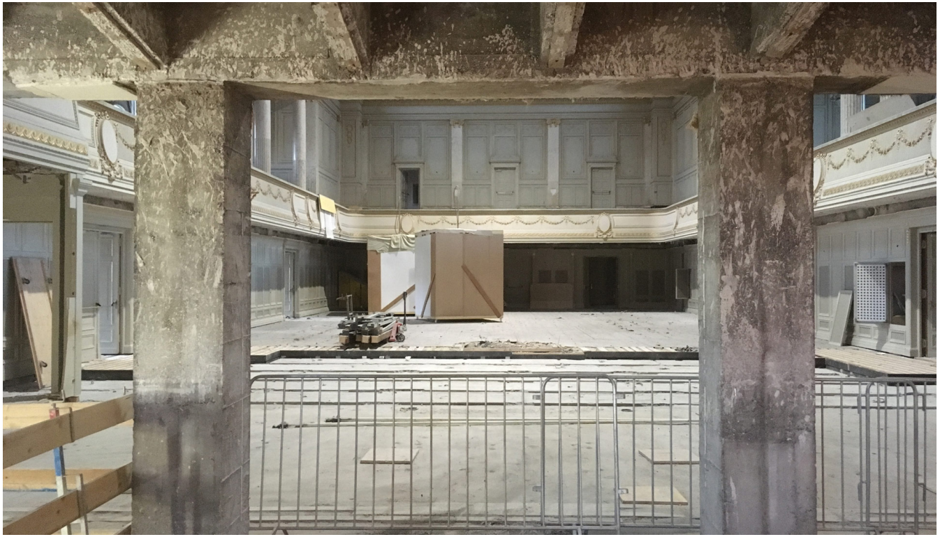
Campanile + Michetti Architekten, Kulturcasino Bern, Baustelle. Pascale Bellorini
