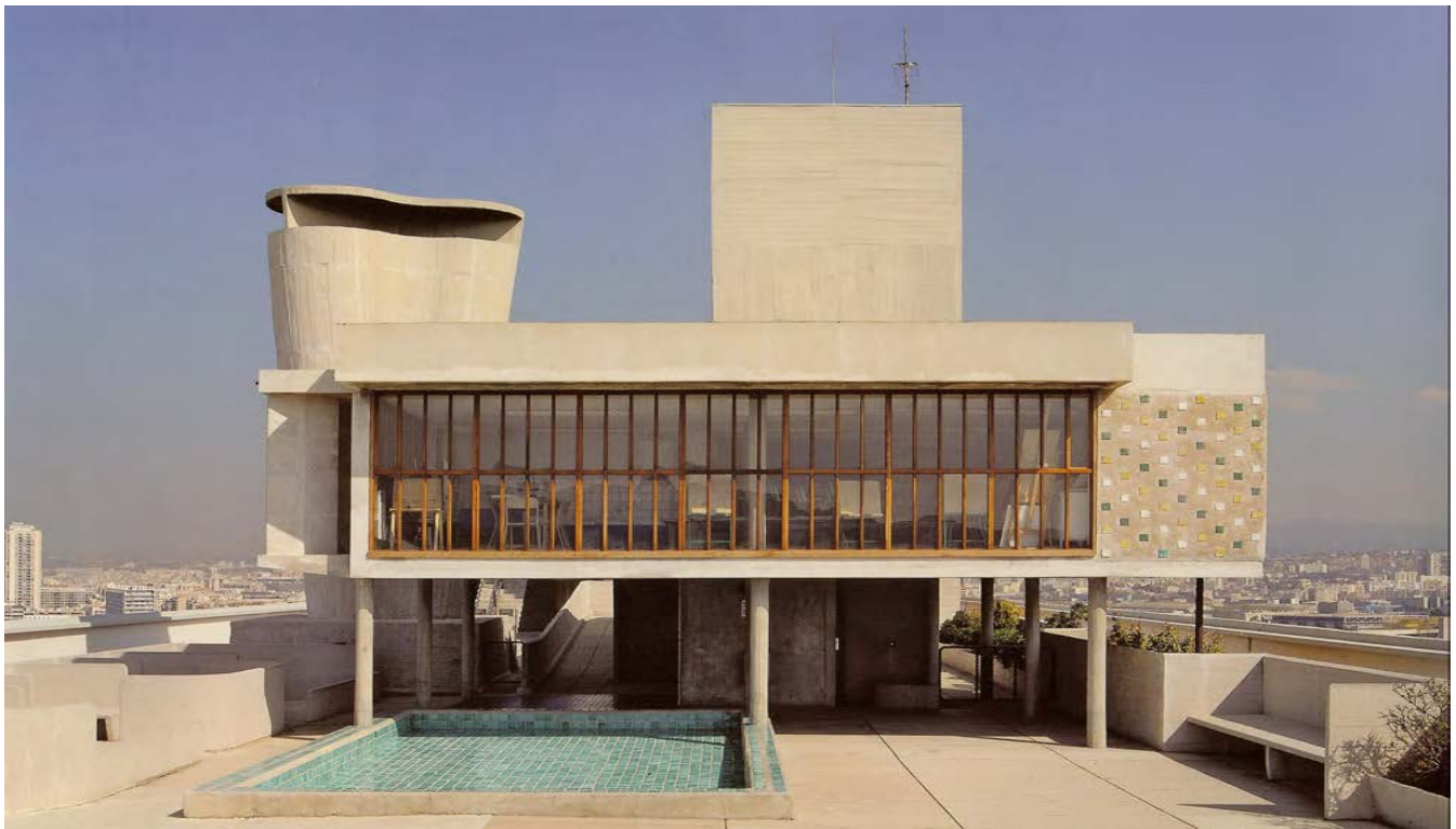
Roof terrace, Unité d'habitation, Marseille, Arch. Le Corbusier
