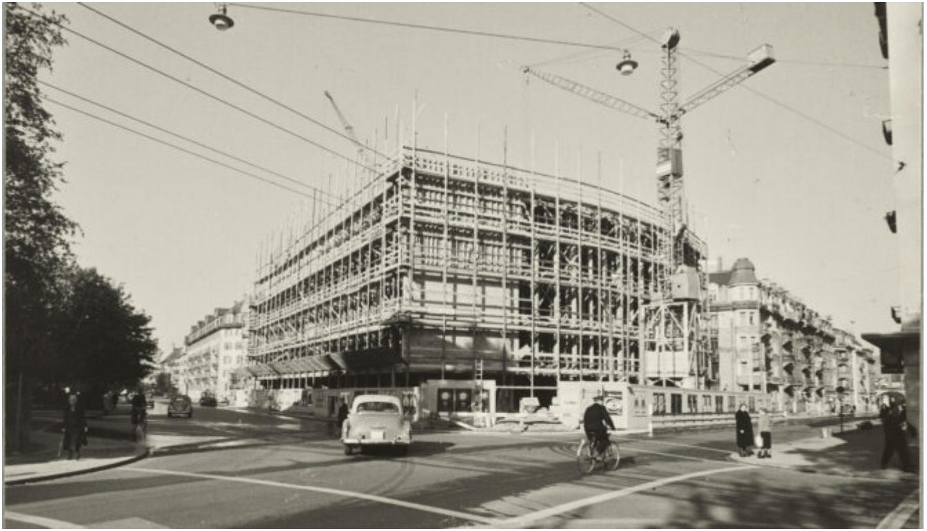
Zürich, Maschinenlabor ETH, Baustelle, 1930-1934, ETH-Bibliothek Zürich, Bildarchiv.
