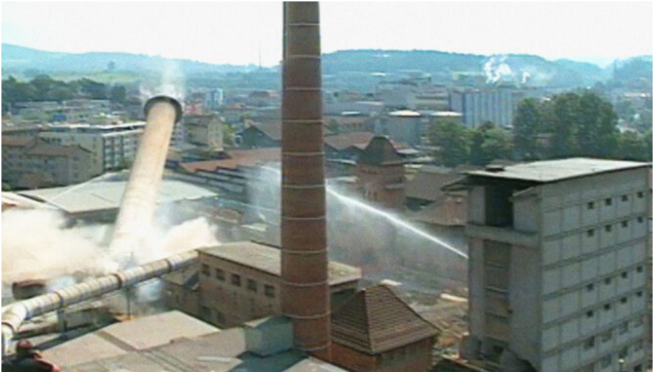
Filmstill der Schornsteinsprengung, 10vor10, 12.01.1994
