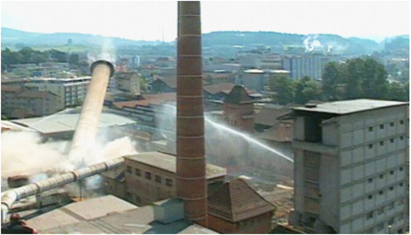
Der Faden reisst – die letzten Jahre der Viscosuisse, Filmstill der Schornsteinsprengung, 10 vor 10, 12.01.1994
