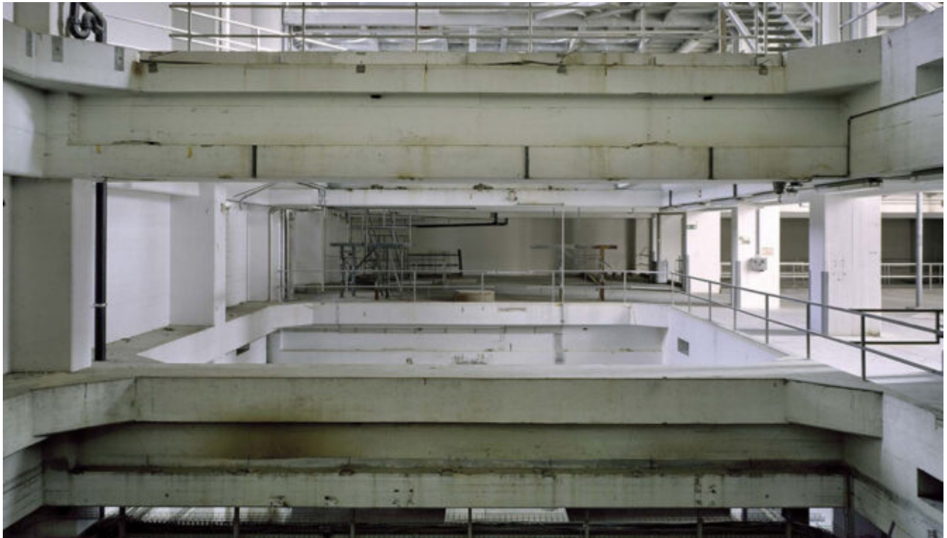
Toni-Areal, EM2N Architekten Fotograf: Roger Frei
