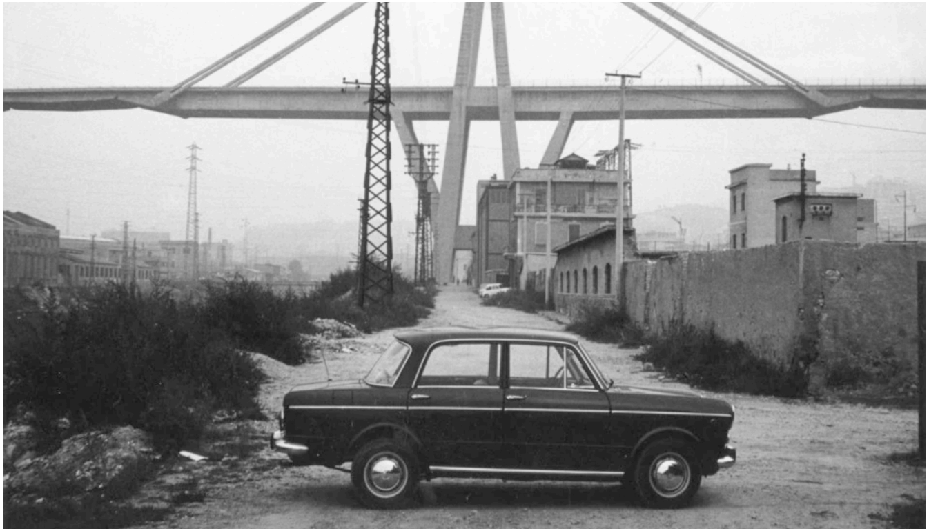
Viadotto Sul Polcevera (Morandi Bridge), 1960 – 67 (Photo: Arno Hammacher, 1967)
